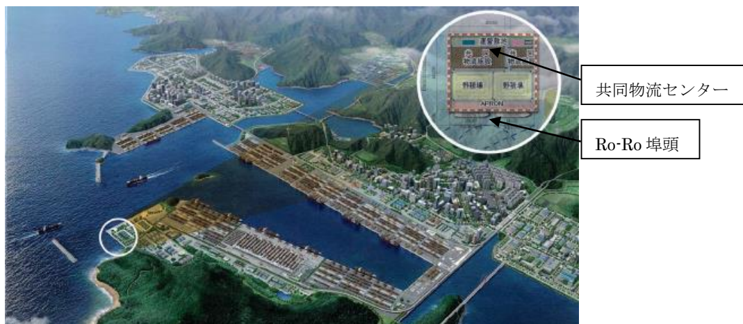
図 3-7 釜山新港では日韓海峡圏 Ro - Ro 埠頭とワンストップ共同物流センター
